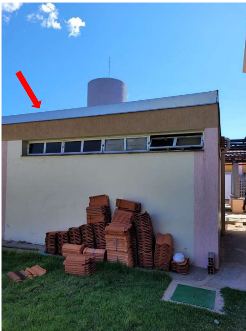
Substituição do telhado existente, com novo caimento e inclinação, conforme projeto arquitetônico em anexo.
