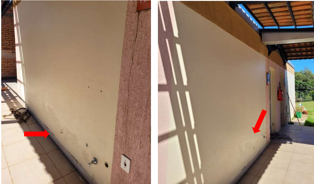
Reparos de fissuras/trincas na parte externa de toda a edificação.
